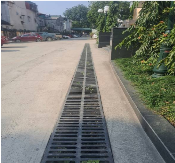
Hệ thống rãnh thu gom nước mưa tại cơ sở
